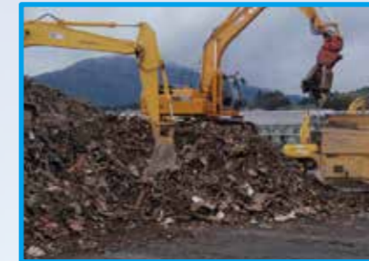
震災がれき・廃棄物の処理
